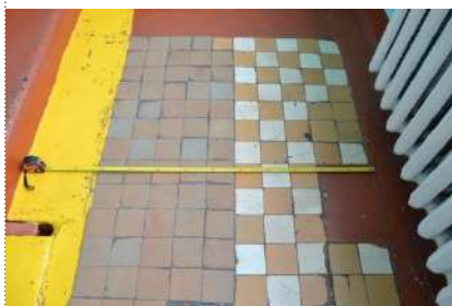
Фото № 33 – Лестница (внутри здания)
