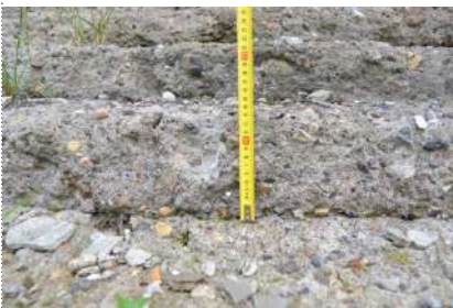
Фото № 57-Пути эвакуации
