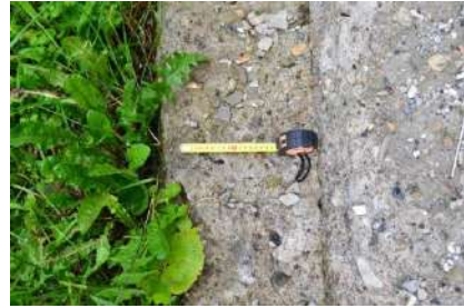
Фото № 56-Пути эвакуации
