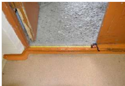
Фото № 46- Пути эвакуации
