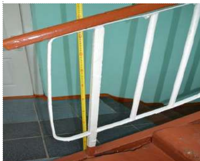
Фото № 34 – Лестница (внутри здания)
