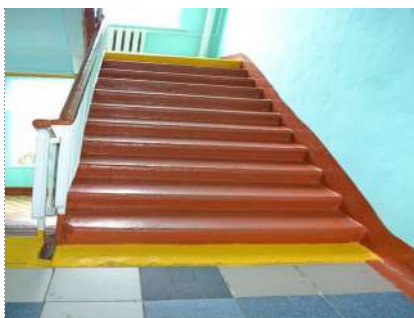
Фото № 29 – Лестница (внутри здания)
