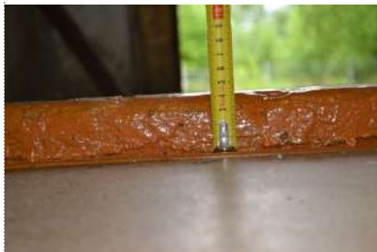
Фото № 47- Пути эвакуации
