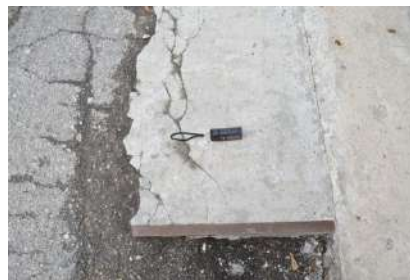
Фото № 8- Входная площадка (перед дверью)
