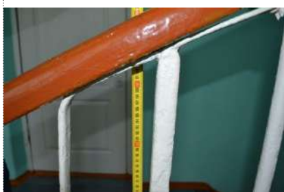
Фото № 35 – Лестница (внутри здания)
