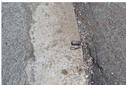
Фото № 11- Входная площадка (перед дверью)
