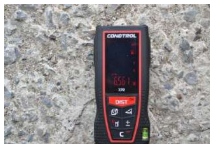
Фото № 10- Входная площадка (перед дверью)
