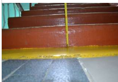
Фото № 30 – Лестница (внутри здания)
