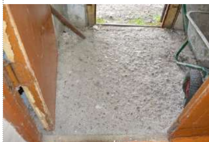
Фото № 48- Пути эвакуации
