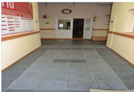
Фото № 21- Коридор (вестибюль)
