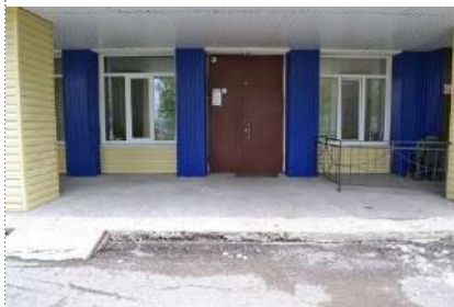
Фото № 7- Входная площадка (перед дверью)
