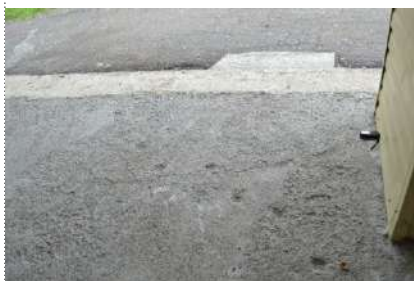
Фото № 9- Входная площадка (перед дверью)
