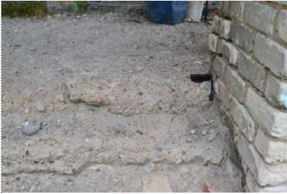
Фото № 55-Пути эвакуации
